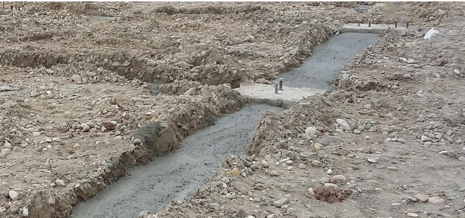
Le béton de propreté est un béton maigre (béton faiblement dosé en ciment). Il est étalé sur le sol ou en fond de fouilles - ou fond de coffre - afin de créer une surface de travail plane et non terreuse. Il protège le sol des intempéries et permet de travailler « au propre » d'où son nom.
