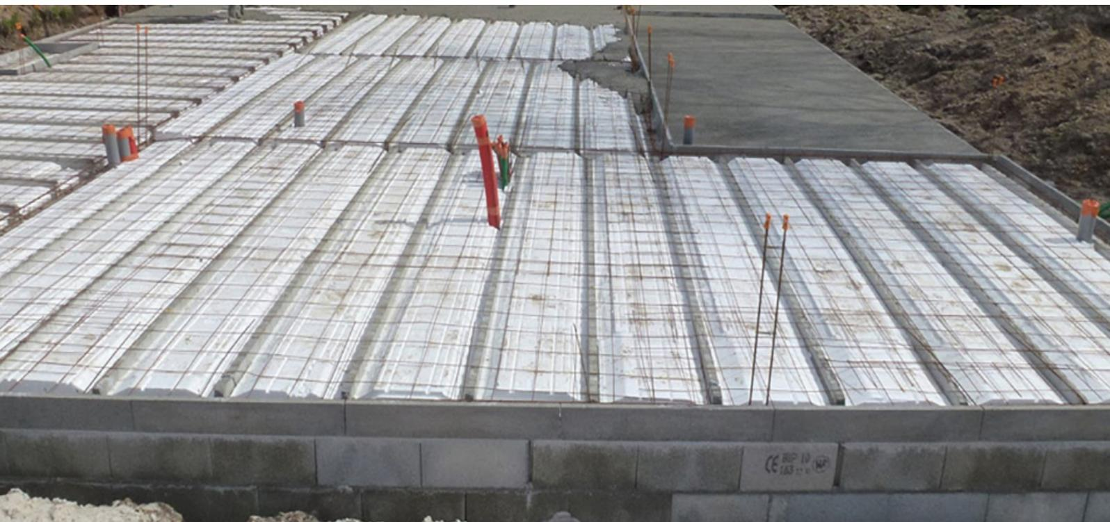
La dalle de compression a pour fonction de limiter l'effet des efforts appliqués et de répartir les forces sur l'ensemble de la surface. D'une faible épaisseur, elle est coulée sur la structure poutrelles hourdis.
